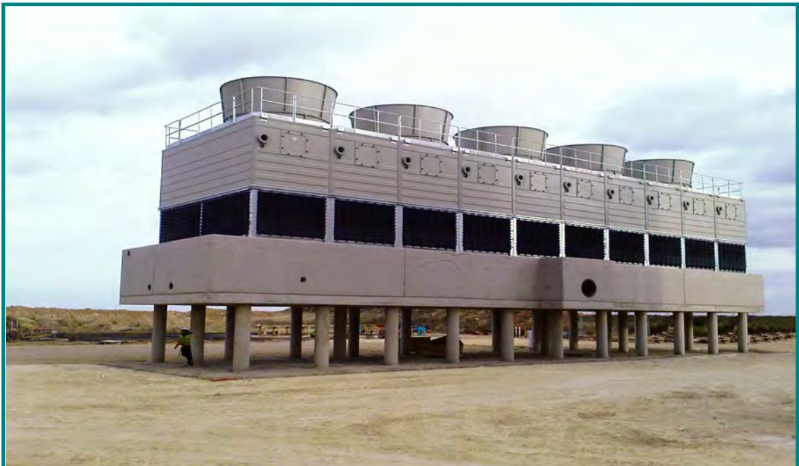
Planta de Biomasa Miajadas (Cáceres) 5 celda de 5.000 kW cada una Total 25 MW
