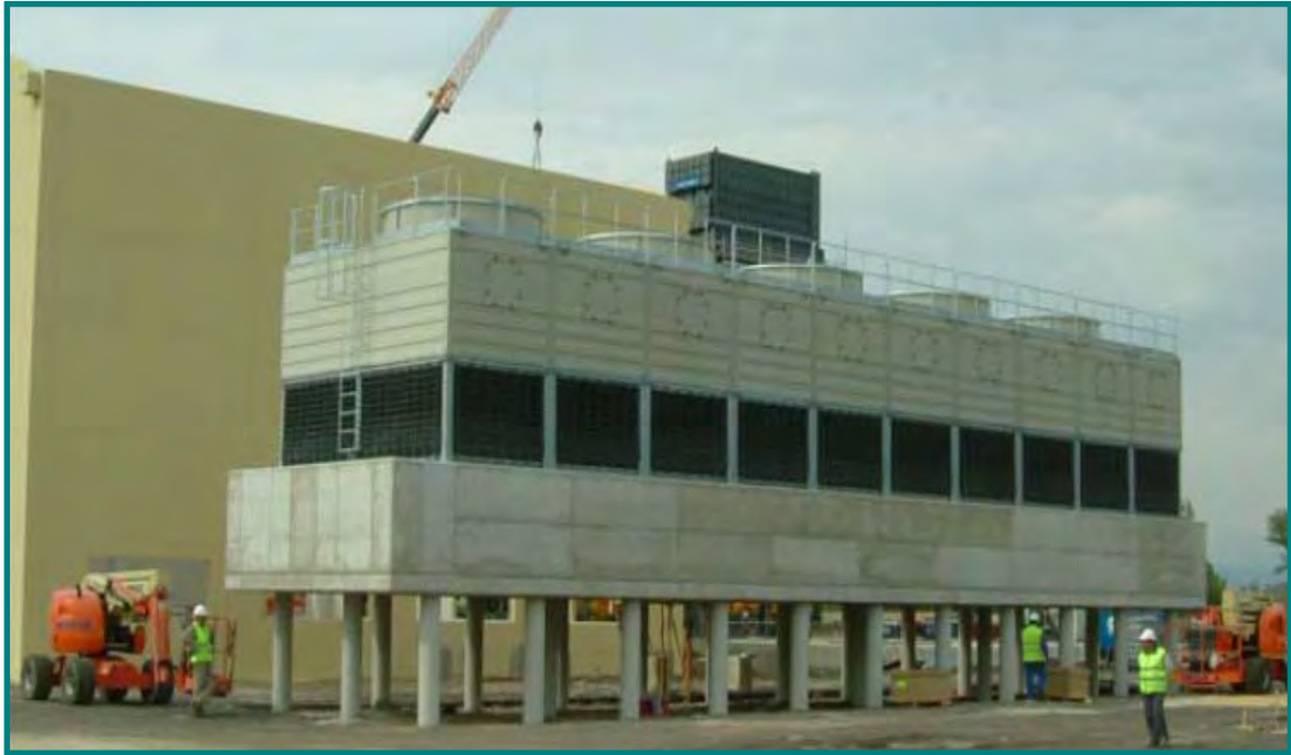
Planta de Biomasa Briviescas (Burgos) 5 celda de 5.000 kW cada una Total 25 MW
